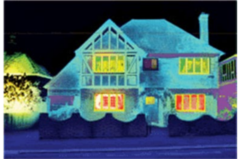
Después de sellar el envolvente del edificio
