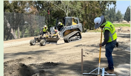
Se termina de nivelar para preparar el
