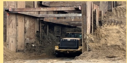
Trabajo en el lado este del túnel para carritos
