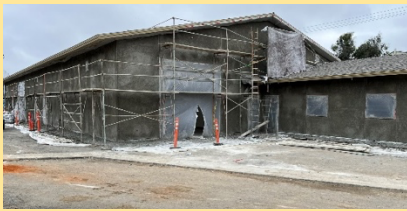
Afuera del nuevo edificio de mantenimiento
